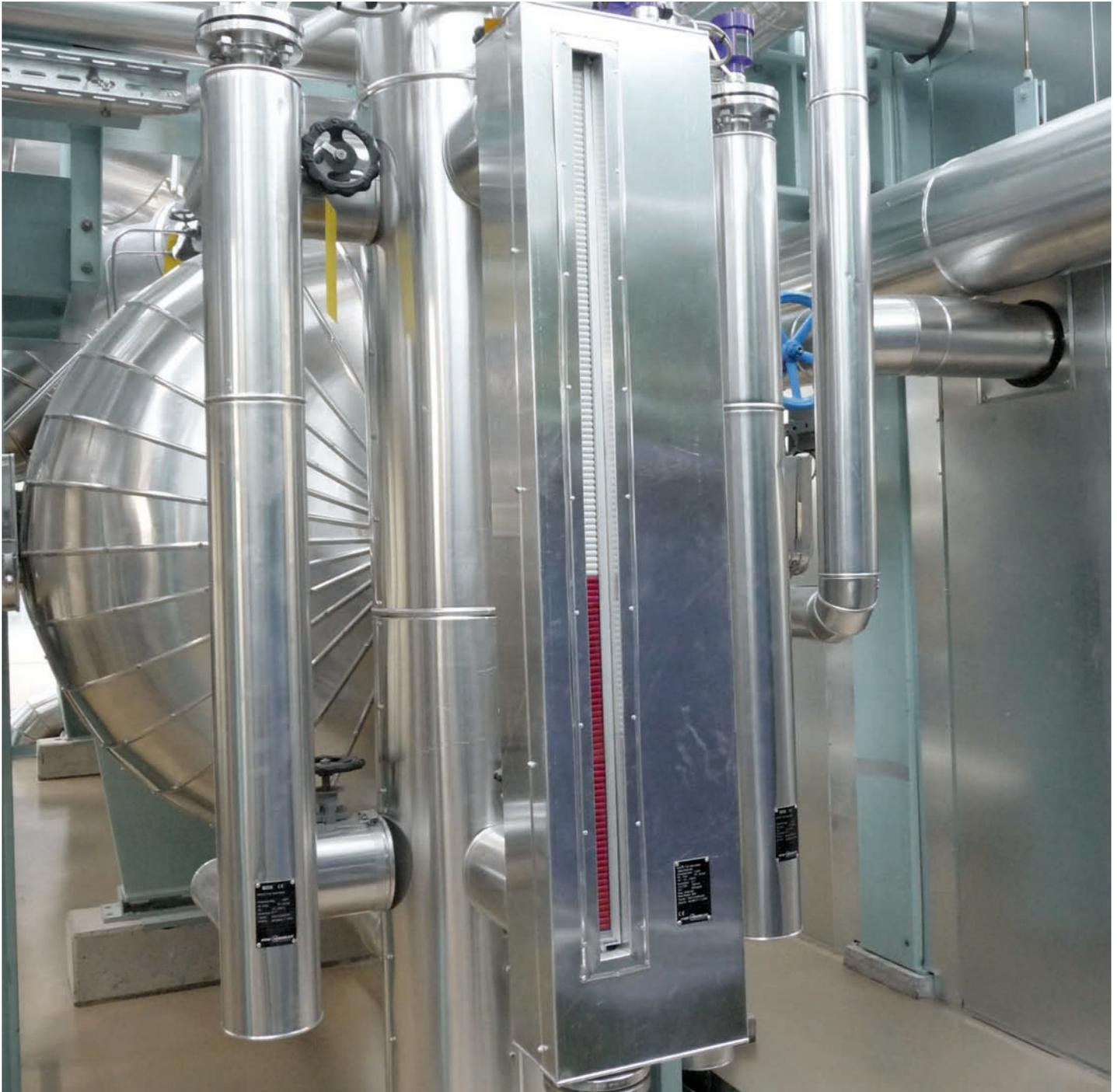
In einem an der Seite eines Behälters kommunizierend angebrachten Bypass-Gefäß bewegt sich ein Schwimmer mit dem Flüssigkeitsstand des zu messenden Mediums. Das im Schwimmer auf Eintauchhöhe positionierte, radialsymmetrische Magnet-system aktiviert mit seinem Magnetfeld gleichzeitig den außen am Bypass-Gefäß angebrachten Magnetrollenanzeiger sowie die Schalt- und Messelemente.
