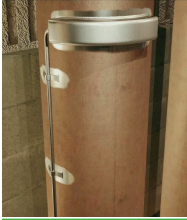
Fachgerechte Verlegung mit Klammern
