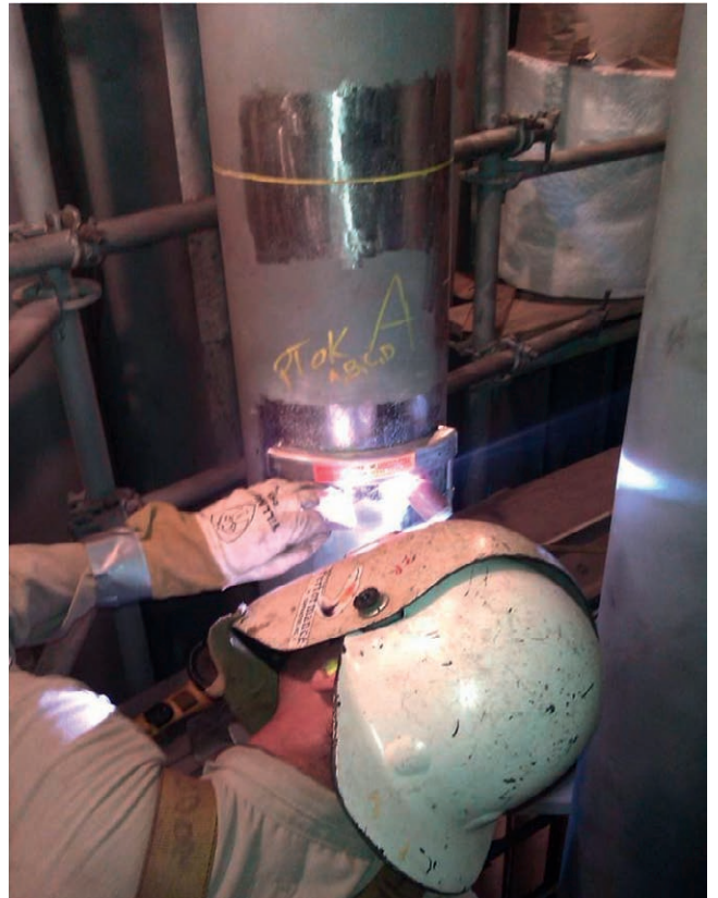
Ausgebildeter Fachmann beim Sensoreinbau
