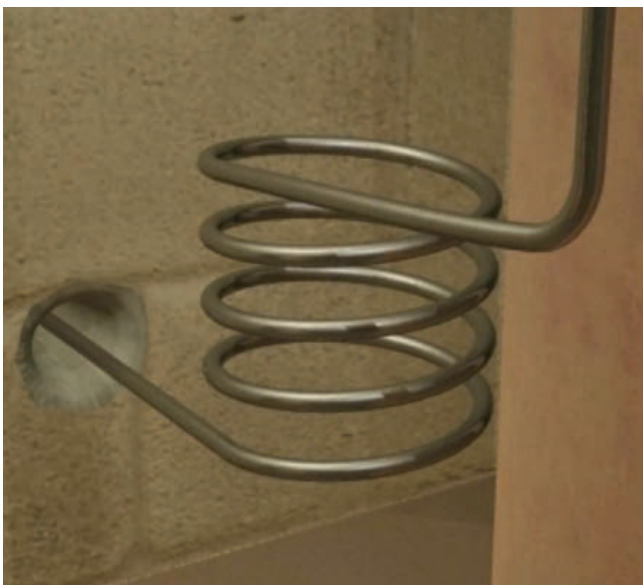
Aus dem Ofen kommende Ausdehnungsspirale
