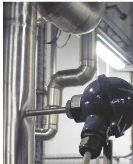
Widerstandsthermometer, eingeschweißt in eine Rohrleitung
